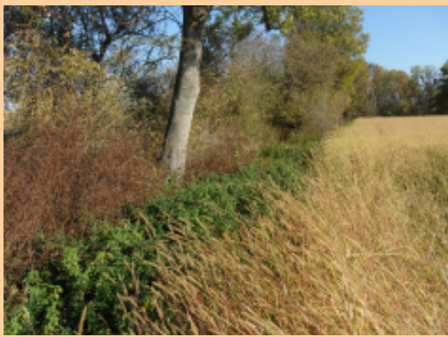
Fossés avant travaux. Source : SRDCBS
