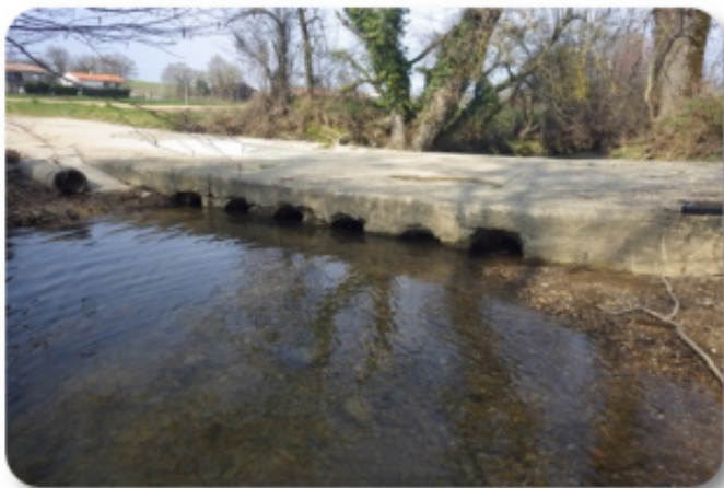
Aménagement d'un seuil et d'un passage à gué sur le Moignans
