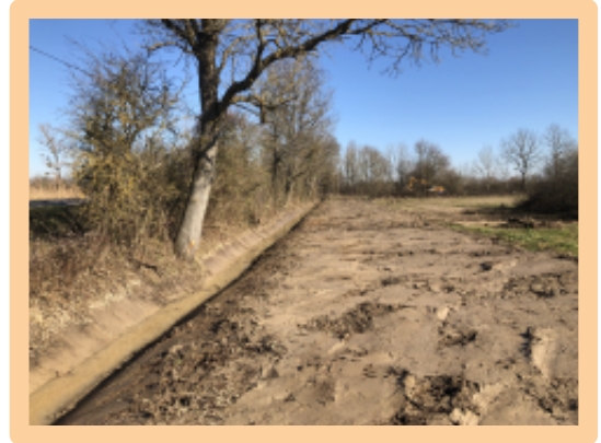
Fossés après travaux. Source : SRDCBS
