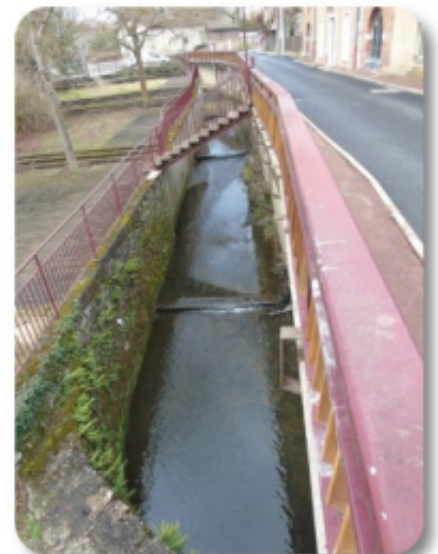
Aménagement de plusieurs petits seuils à l'aval du Relevant
