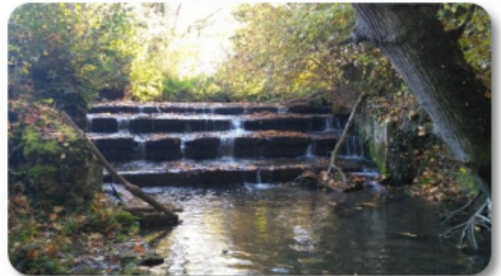
Aménagement de 3 seuils sur la Calonne
